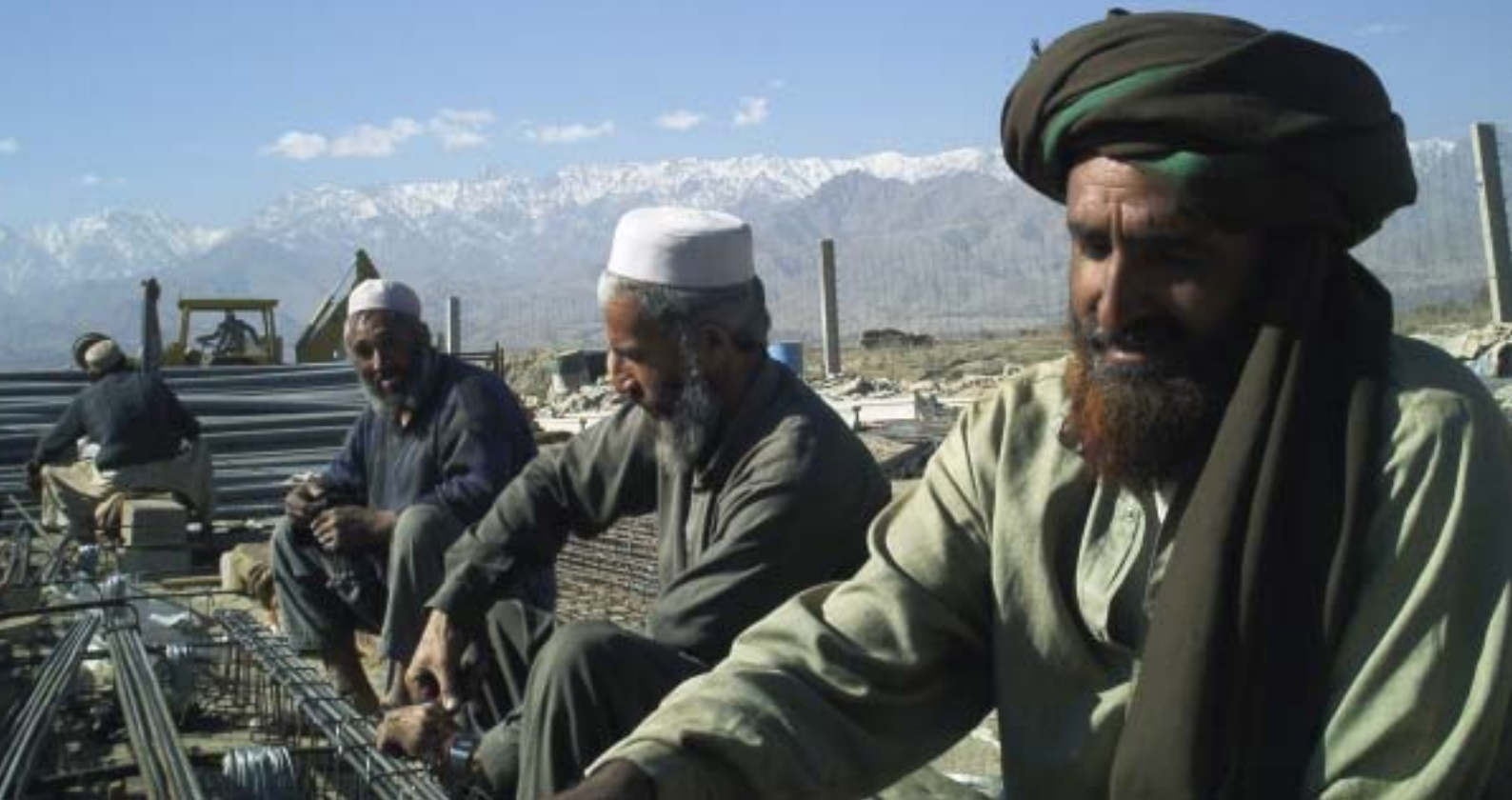
Betonfabrik von Shelter Now: Afghanen beim Wiederaufbau
